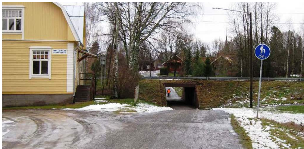
Valtatien alikulku nähtynä Meijerintieltä Keskuskadun suuntaan. Valtatien toisella puolella näkyy Poukan talo ja Pilppulan pihapiirin rakennuksia sekä kirkon kellotapulnin huippu., kuvassa vasemmalla entinen suutari Elon asuinrakennus. Kuva Sito Oy 2011.
